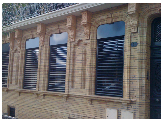
Fig.11 Exemple de pose avec lambrequin
