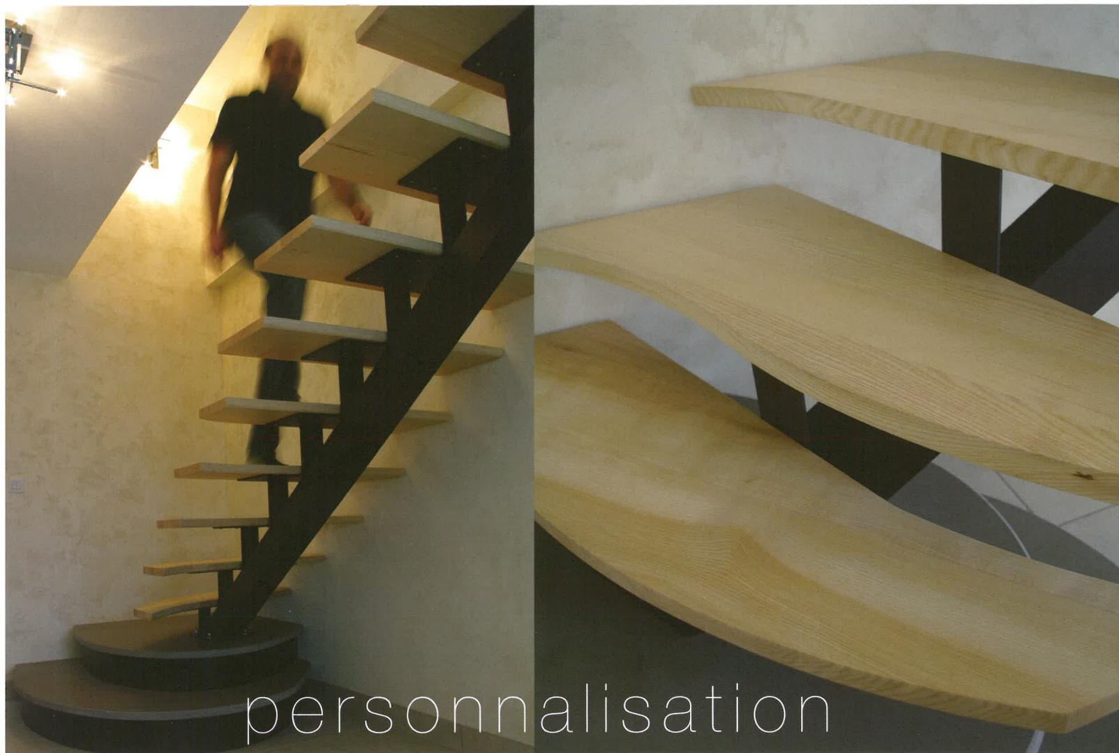
Cet escalier entièrement conçu avec le client est un modèle unique, avec une crémaillère centrale métallique spéciale. Les 5 premières marches évasées avec un chantournage spécial. Les paliers de départ sont en pierre taillées sur mesure pour ce projet. L'ensemble des marches est en frêne, vernis.
